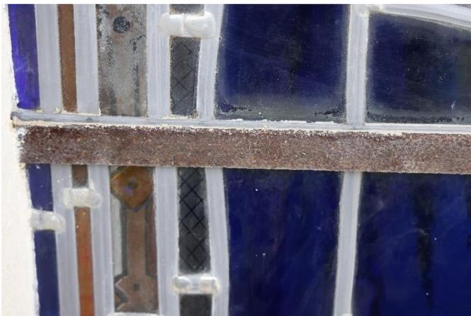
Baie 0 : A la repose, l'étanchéité a été réalisée au mastic.
