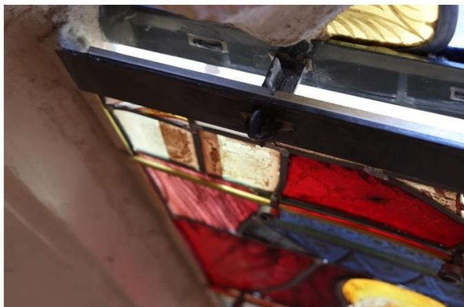
Baie 2 : Modification de la serrurerie. Sur les barres de chaînage ont été vissées des pannetons pour permettre la pose d'une double verrière et du panneau ancien en avant.
