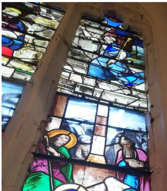
Pour la dépose, nous avons procédé à l'élimination des calfeutrements périphériques qui étaient réalisés à la chaux pour la plupart et au ciment pour certains.
